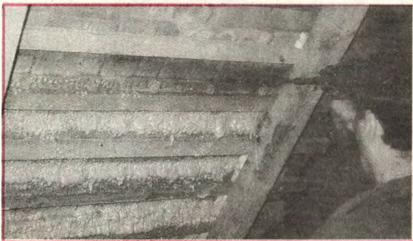
4. Cseréphejalást és a tetőszerkezetet a belső szigetelés előtt gondosan rendezni és rögzíteni kell. Erre kitűnő a PUR-hab belülről felszórása.
